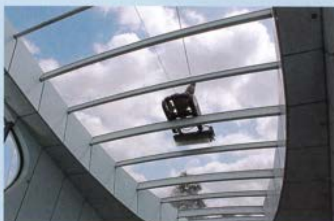
Bei der Reinigung der Bahnsteigüberdachung. Die Maschine wird per Funkfernsteuerung bedient.
