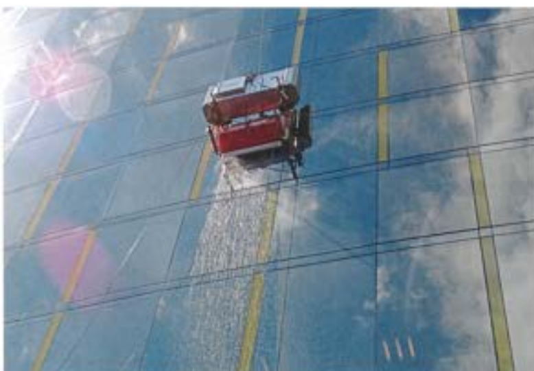
Gearbeitet wird von oben nach unten, damit kein Schmutzwasser auf die gereinigten Flächen läuft.
