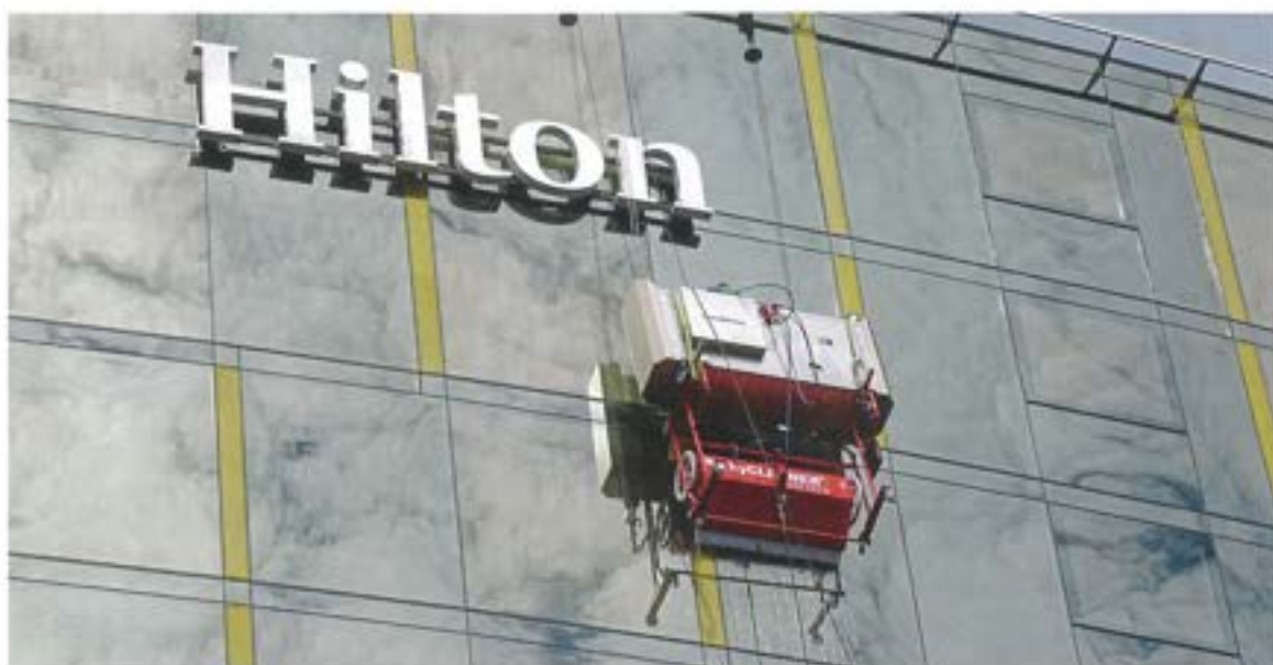
Gereinigt wird ausschließlich mit Wasser in 1,60 Meter breiten Bahnen.
